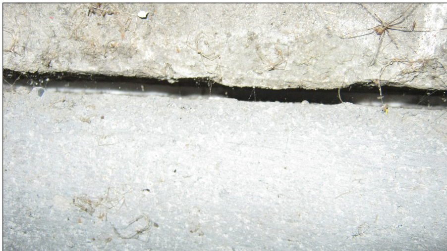
Foto: IMG_4090.JPG Fehlender Mörtel, 100mm, von 12 bis 12 Uhr
