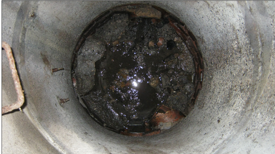
Foto: IMG_4109.JPG Korrodierte Steigeisen, 4 Stück , Schadensanfang
